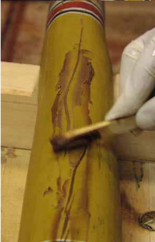
Étape 3 : Enduire et remplir les fissures avec une languette plate. Être sûr que toutes les fissures sont complètement remplies
