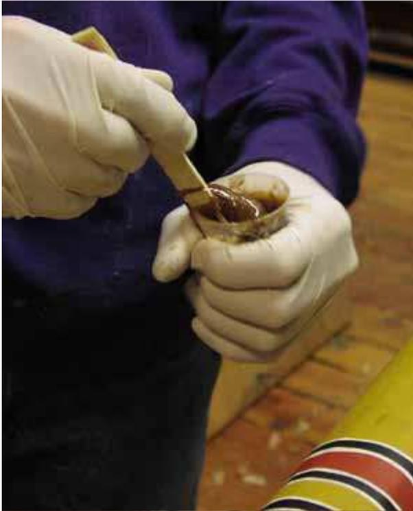
Étape 2 : Le colmatage. J'emploie une résine époxyde avec durcisseur. Ajuster la viscosité en fonction de l'épaisseur de fissures.
